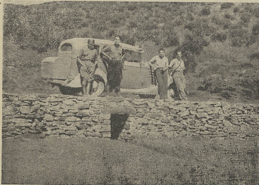
Alcantarilla construida por el 566 Batallón
