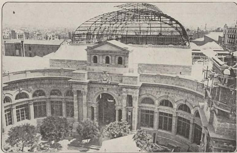
Vista general del Palacio de Artes Industriales y Aplicadas. El armazón de hierro de su cúpula ha sido construido por la razón social «Materiales para Ferrocarriles y Construcciones».
