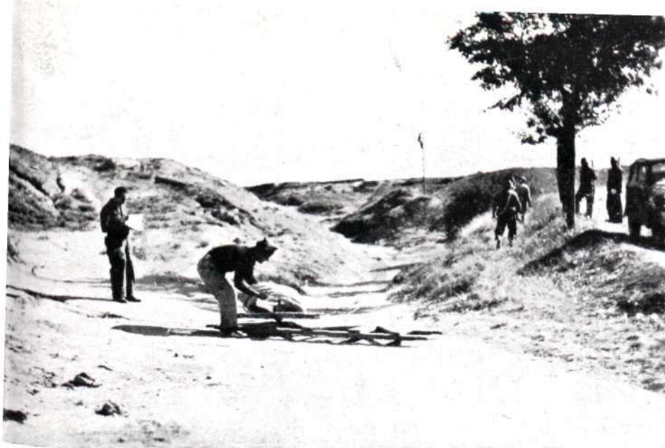
Comenzando el tendido de una nueva línea telefónica en las avanzadas de Huesca.
