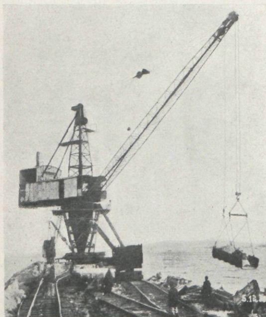
Figura 3.ª—Grúa Pillar, especialmente proyectada para la construcción del rompeolas principal del puerto de Haifa.
