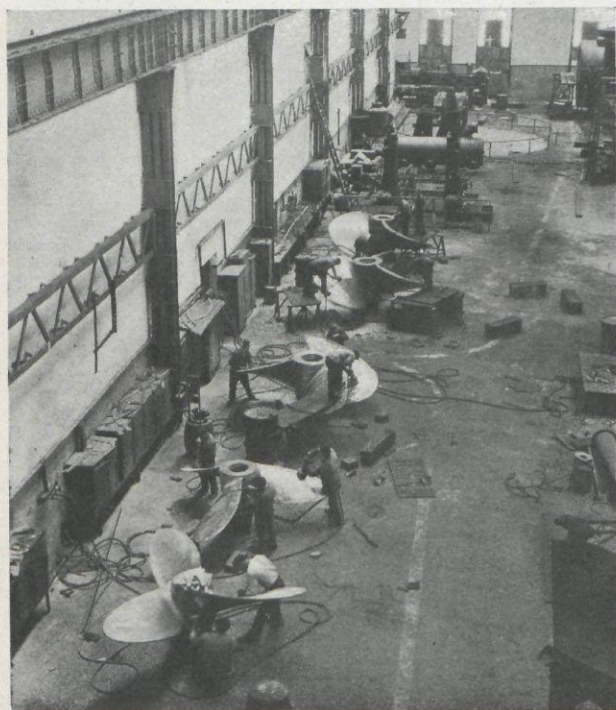
Figura 8.ª—Nave destinada al pulimento de hélices
