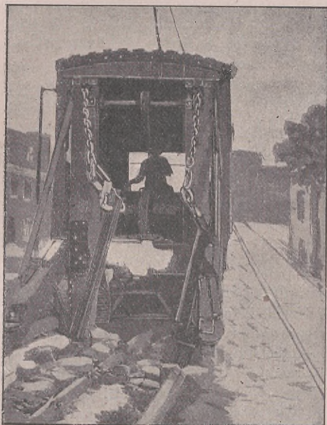
LA MÁQUINA LEVANTANDO LOS TROZOS DE RIELES ROTOS
