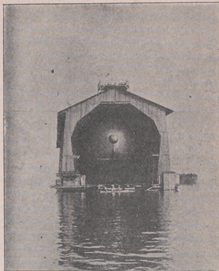
VISTA DEL COBERTIZO, DE FRENTE
