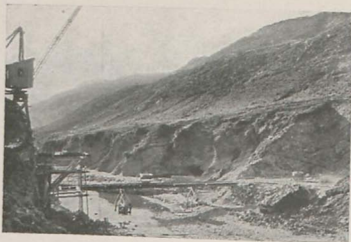
FIG. 6.* — OBRAS PARA LA CONSTRUCCIÓN DE LA CENTRAL HIDRO-ELECTRICA DE CAMPO. SE DESTACAN EN LA FOTOGRAFIA, COMO EN GRAUS, TRES FASES DE ASURCAMIENTO DEL RÍO
