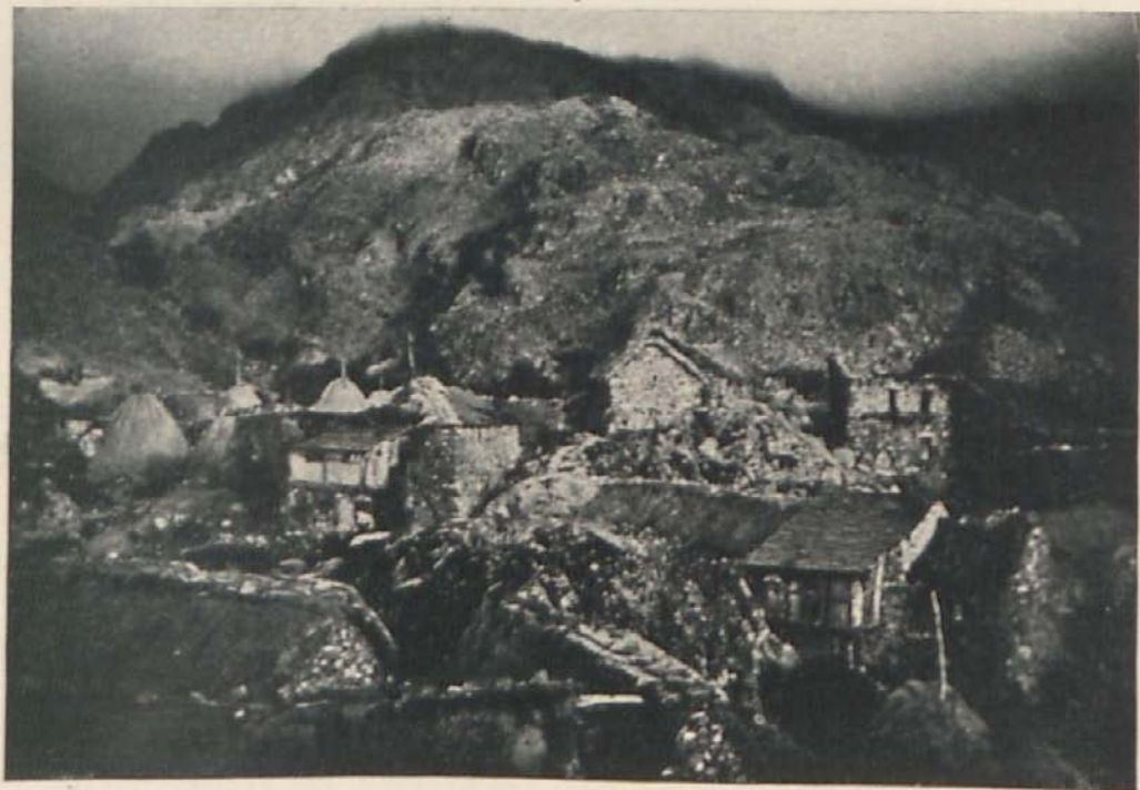
RIBADELAGO. VISTA PARCIAL
