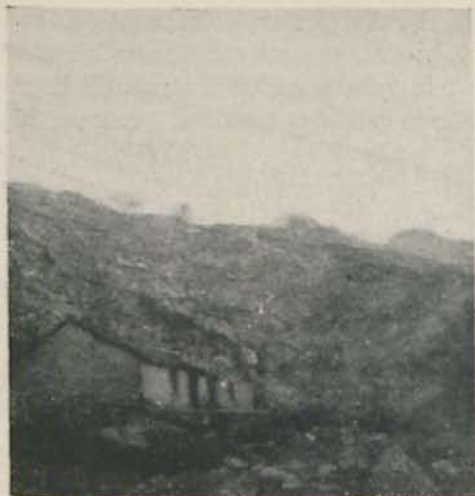
FIGURA 6.—PRIMITIVA CONSTRUCCIÓN DEL REFUGIO DE LA RENCLUSA
