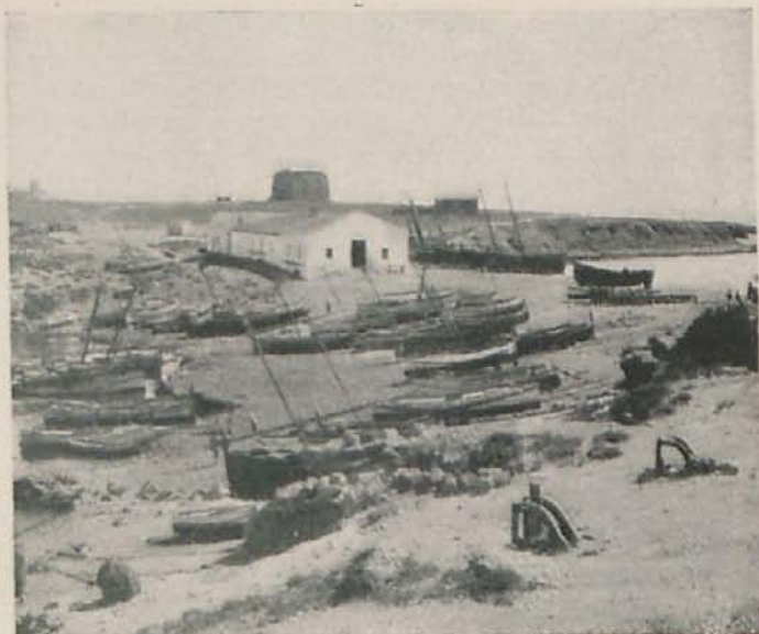
LA FLOTA PESQUERA DE TABARCA. AL FONDO, EN EL CENTRO, LO QUE QUEDA DEL ANTIGUO CASTILLO-FORTALEZA DE SAN PABLO, Y A LA IZQUIERDA, MÁS LEJOS, EL FARO.
