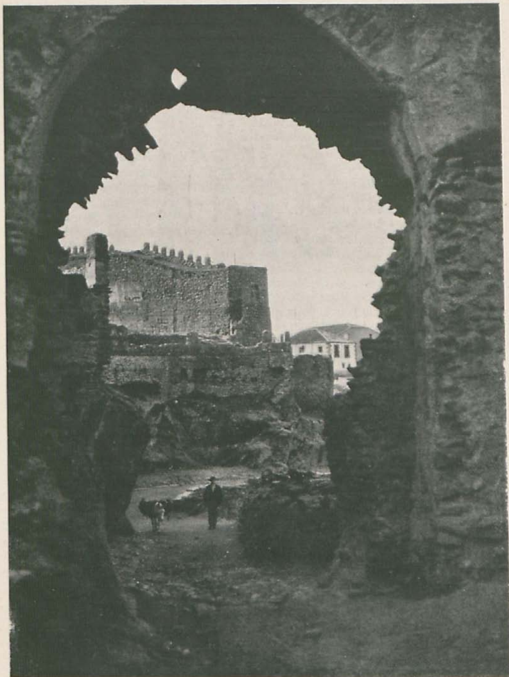
BUITRAGO. RUINAS DE LAS ANTIGUAS FORTIFICACIONES.
