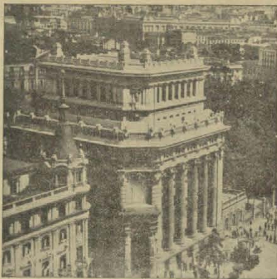
Edificio del Banco Central.
