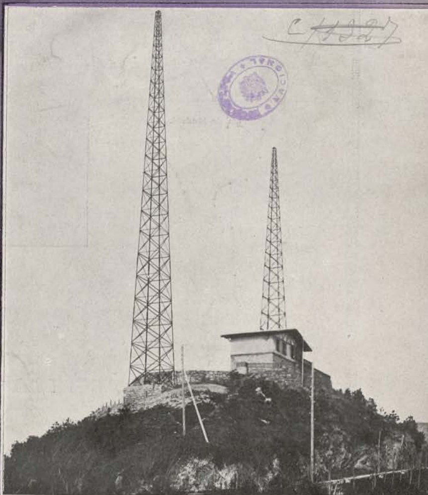
Mástiles, antena y edificio de la emisora de San Sebastián, que se levantan en el monte Igueldo, de la bella población donostiarra.
