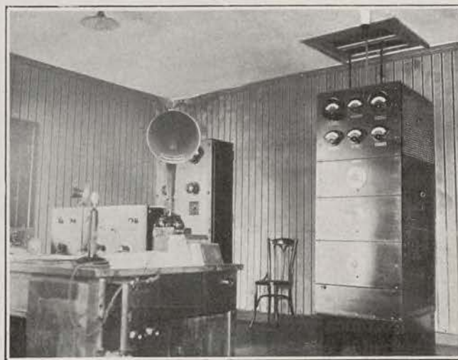
Equipo transmisor (Edificio Monte Igueldo.)
