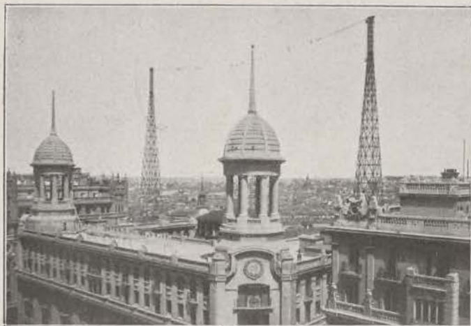
Mástiles y antenas de la emisora Unión Radio de Madrid
