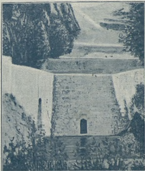
Diques de segundo orden en el torrente Arratiecho (Biescas)
