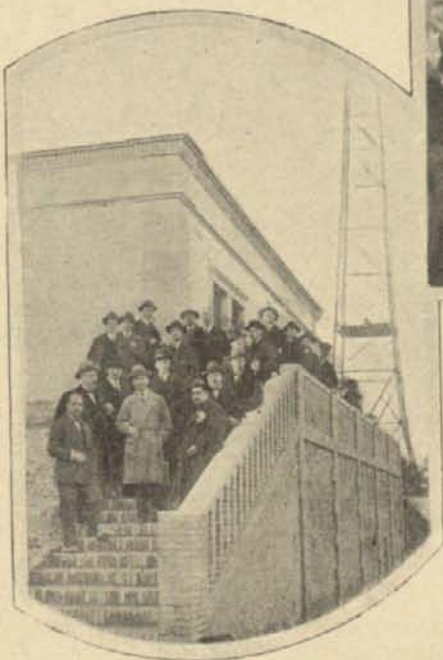
Los invitados al banquete inaugural, visitaron después el pabellón de instalaciones
