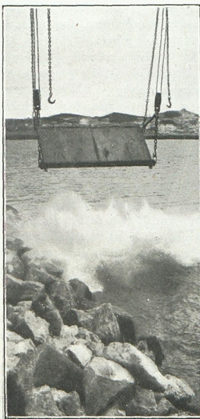
Momento de caer al mar la escollera de primera categoría en el dique-muelle Norte
