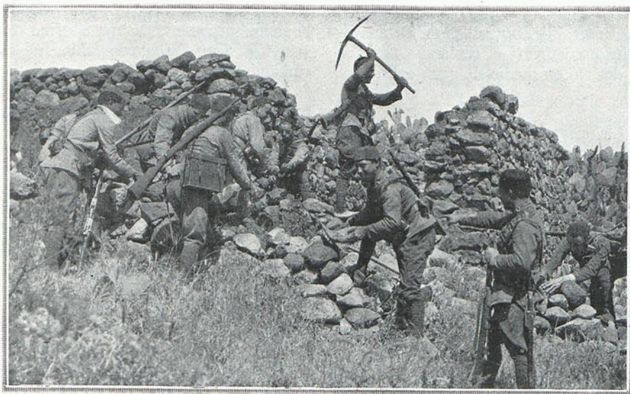
Trabajos de fortificación en una avanzadilla
