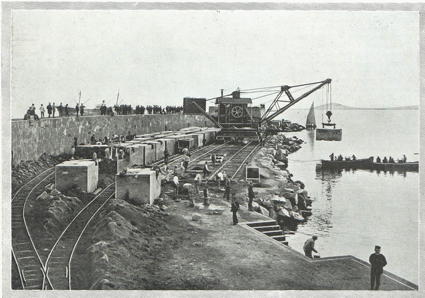
Construcción de la segunda línea del dique NE. con bloques de cemento
