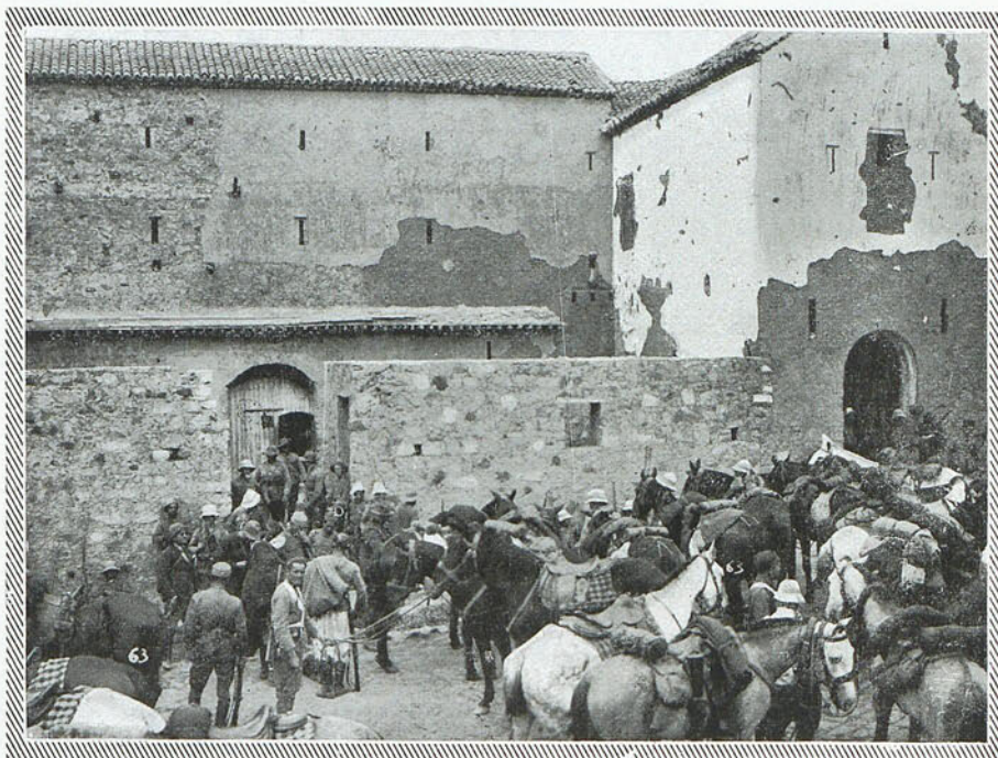
Exterior de la cárcel de Tazarut en cuyas paredes puede apreciarse el efecto del bombardeo
