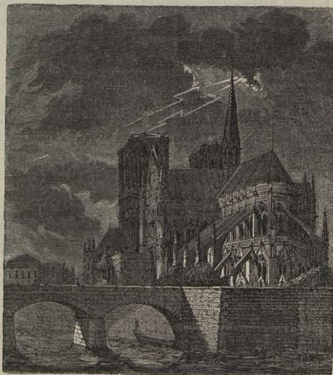
Efectos de una descarga eléctrica sobre un edificio.
