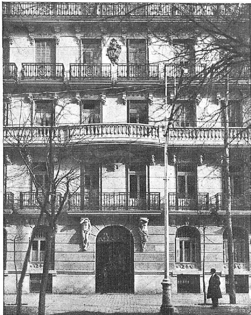
Detalle de la fachada principal.
