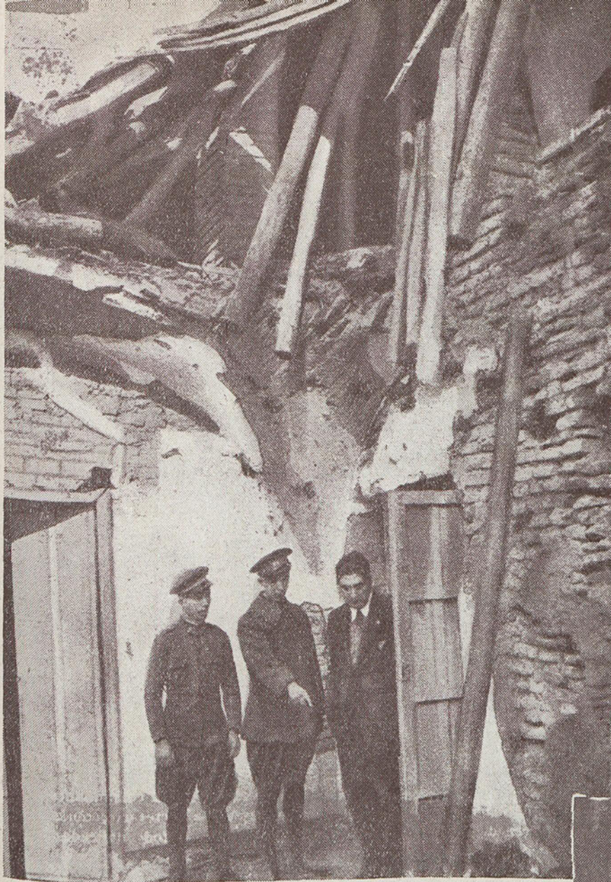
En el edificio derrumbado por el tronar de la artillería, un soldado señala el lugar donde cayó muerto Pío Sopena
