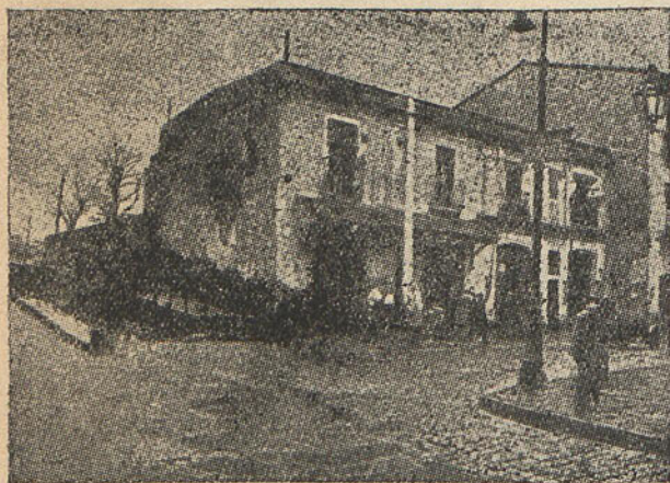
Otra vista del mismo mercado incendiado.
