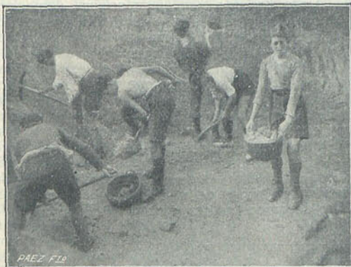
Los exploradores de mayor edad, en continuo trabajo voluntario, actúan como zapadores abriendo zanjas para los cimientos de sus albergues en el Campamento permanente.
