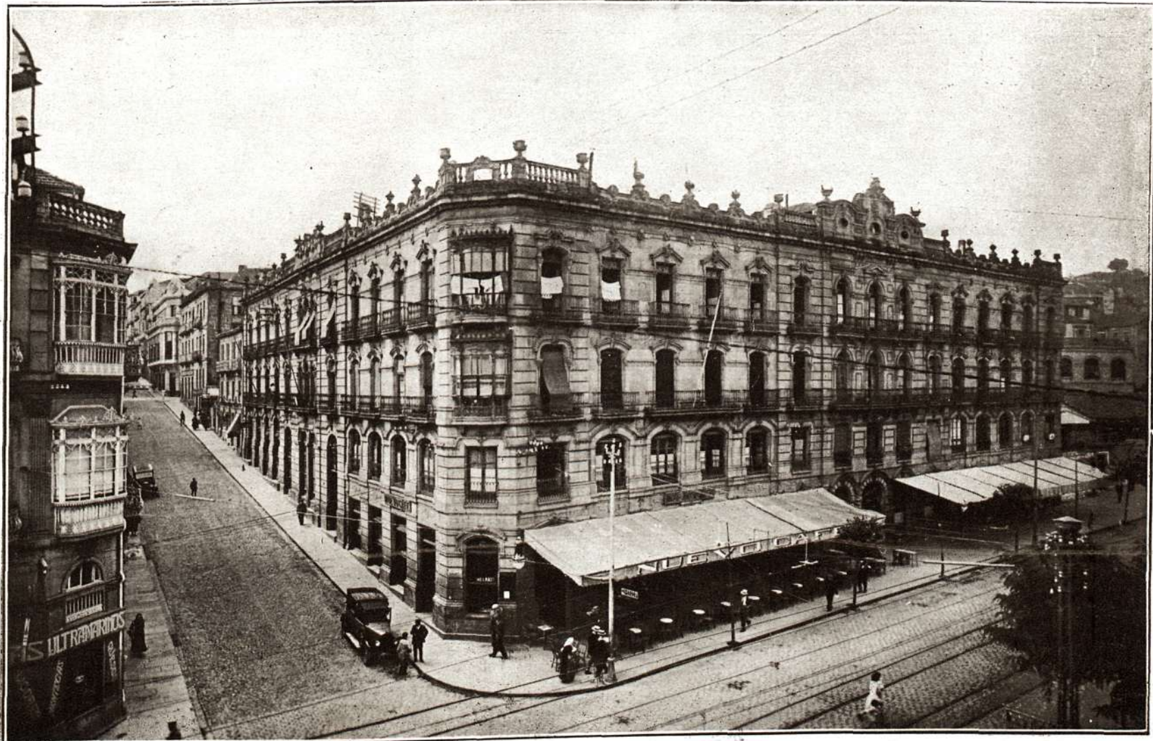
Edificio en el que están instaladas las oficinas de los Cables inglés y alemán, sito en el cruce de la calle de Policarpo Sanz y Velázquez Moreno.
