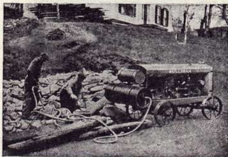
Compresor de aire, portátil SULLIVAN en trabajo de carreteras.
