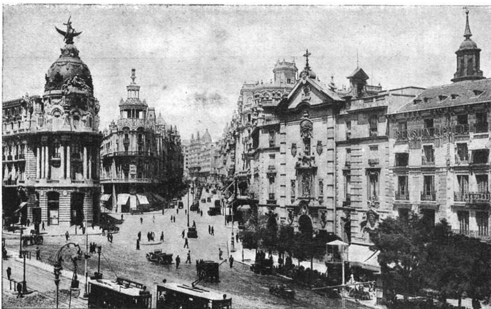
MADRID.—Entrada por la calle de Alcalá a las grandes avenidas Conde de Peñalver y Pi y Margall
