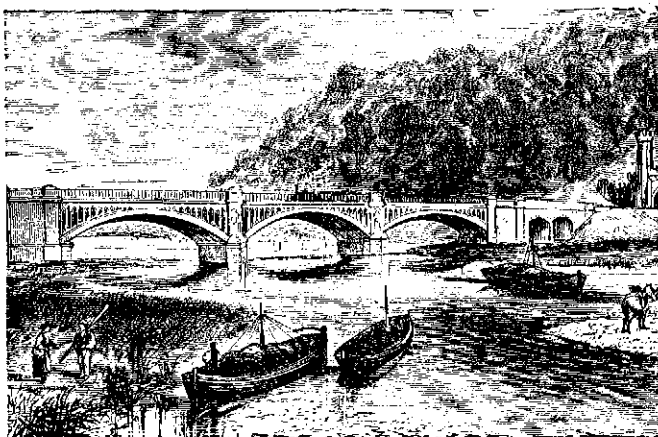
Puente de Worcester.
