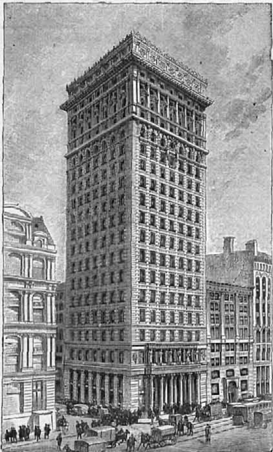
Edificio de la «American Security Company» en Nueva York
