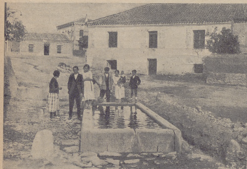
La fuente, tal y cómo fué construída, tampoco se transforma en lavadero.
