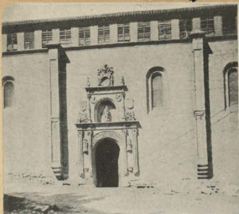
Salamanca. Fachada de Iglesia de las Dueñas.
