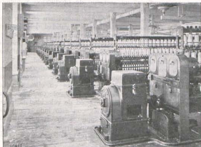
Fig. 1. — Sala de continuas, accionadas individualmente por motores de colector
