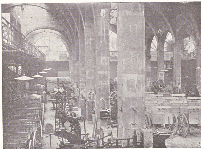
Las naves más antiguas vistas en conjunto. Estado actual. (Foto. A. Goitia).
