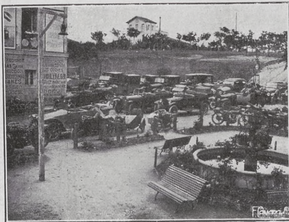
Vista de la parada de «autos» de casa Camorra, tomada desde el jardín.
