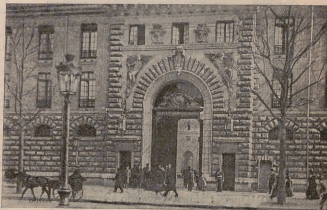
Puerta principal del cuartel.
