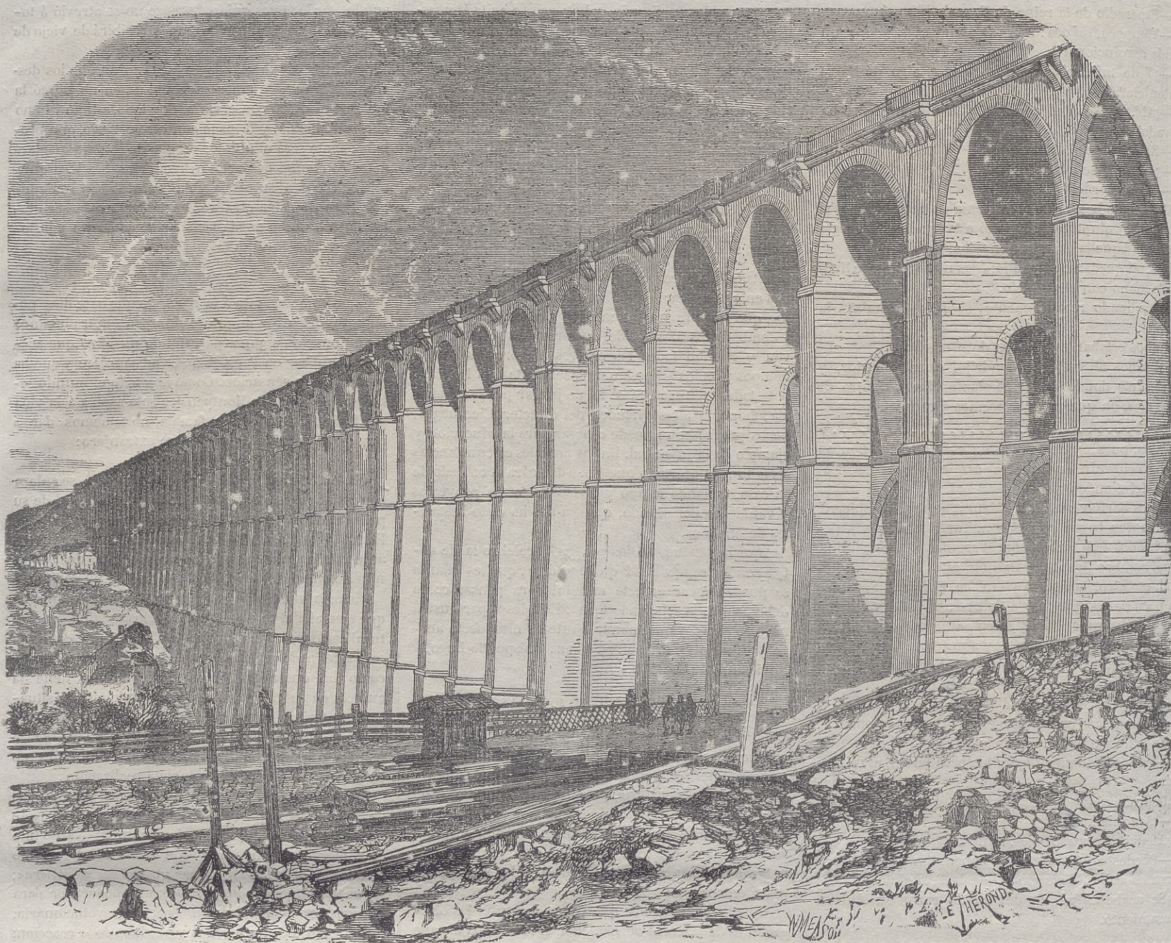
PUENTE-VIADUCTO DE CHAUMONT.
