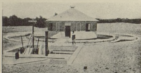
Vista de la instalación depuradora de las aguas negras de Mercedes
