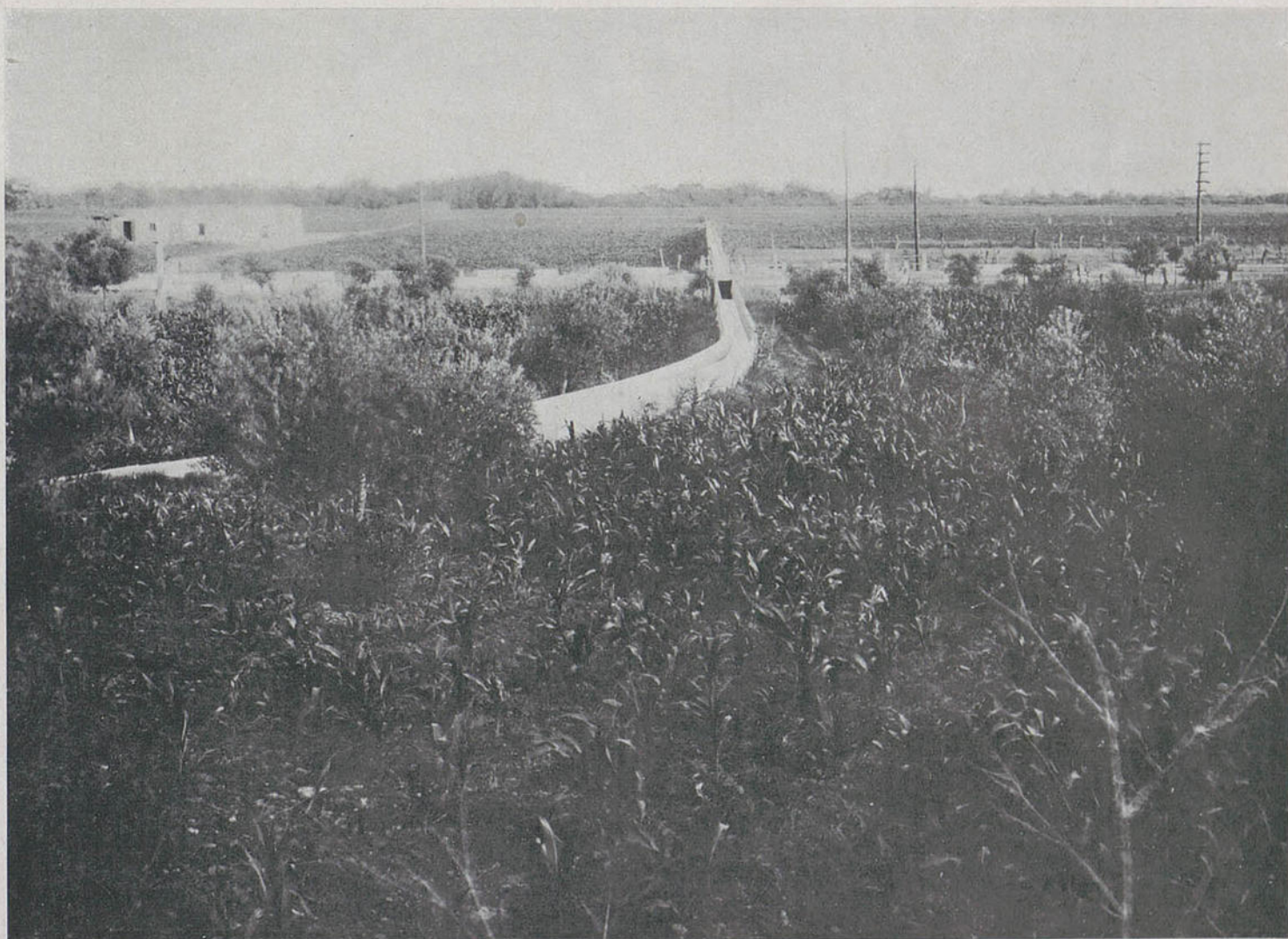
Acequia de Mocetón y cruce con la carretera de Madrid a Cádiz.
