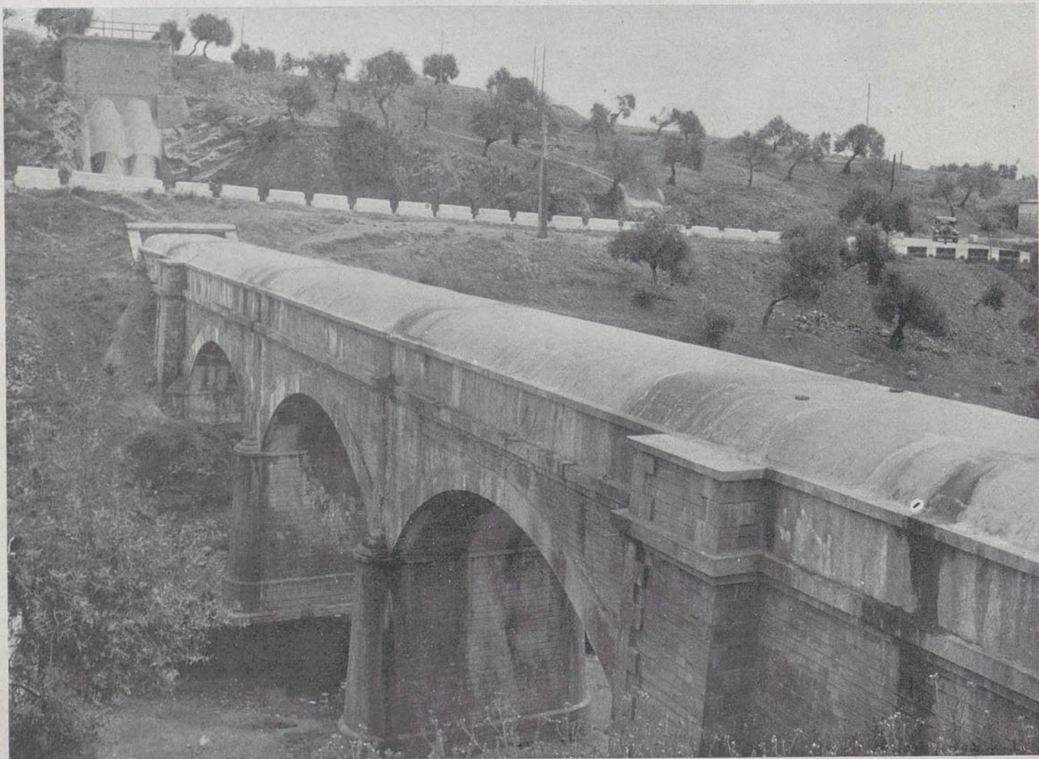
Sifón de Pedroches y cruce de la carretera de Almadén.
