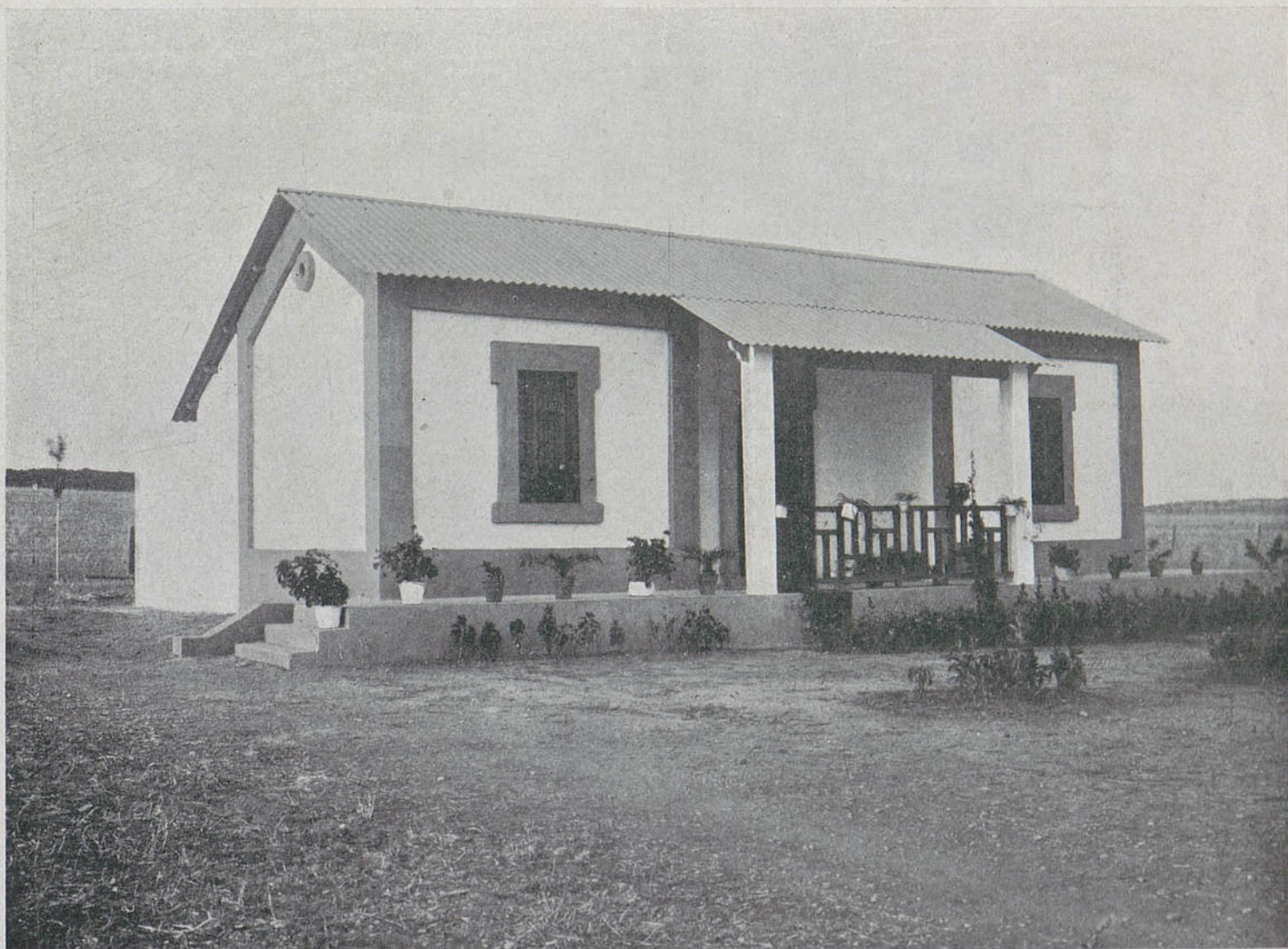
Casilla para guarda del canal.
