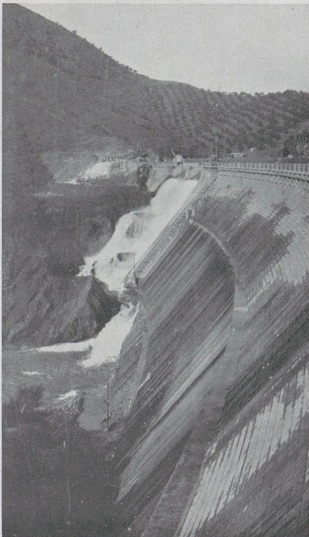
Presa y aliviadero de superficie.
