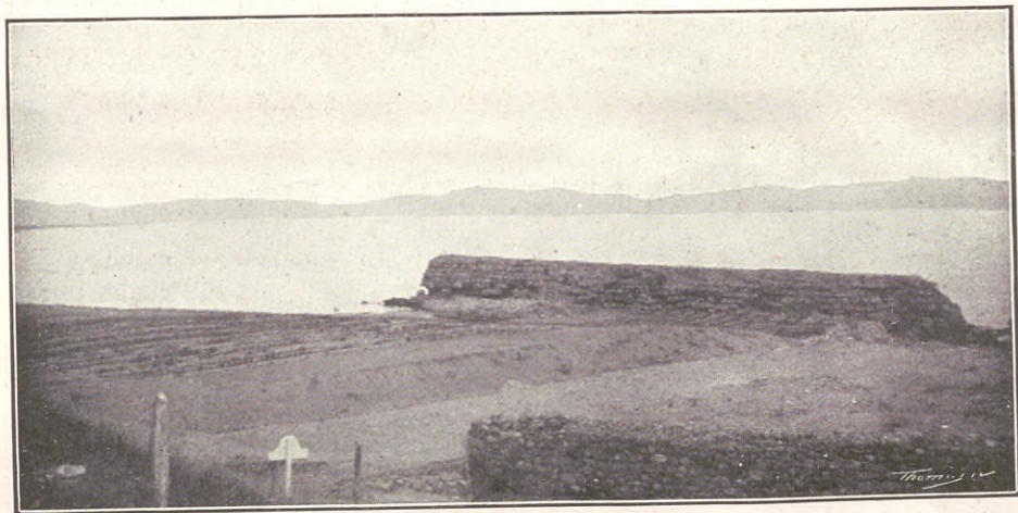
MURALLA DEL PUERTO GRIEGO
