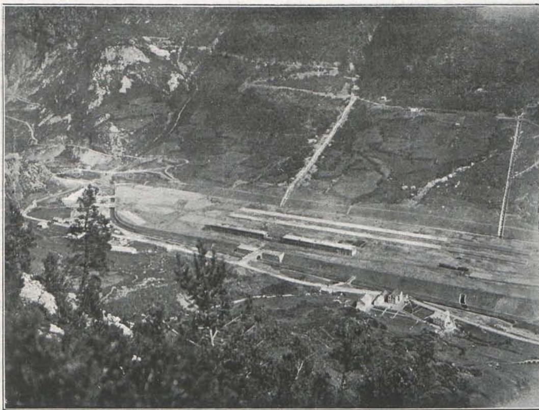
Explanada de la Estación Internacional. Río Aragón, canalizado, y torrentes Cargates y Epifanio, desviados y canalizados.
