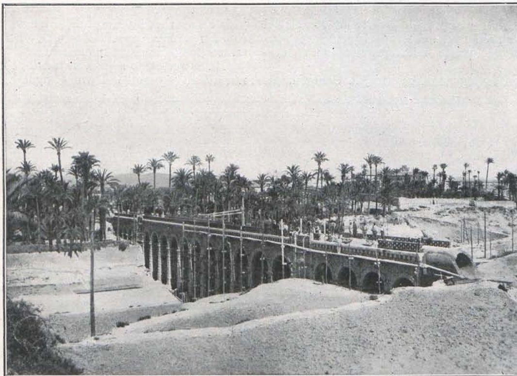
Construcción del viaducto sobre el Vinalapó.
