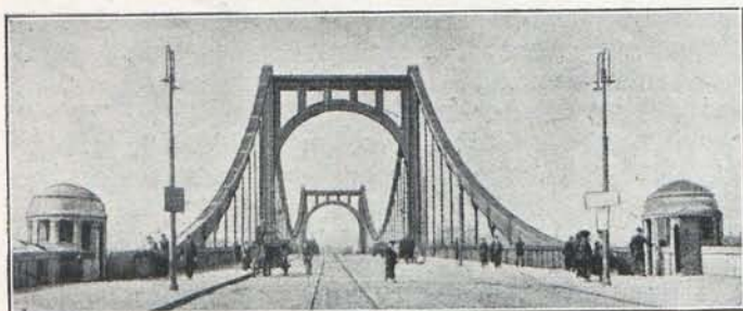
Vista del puente.
