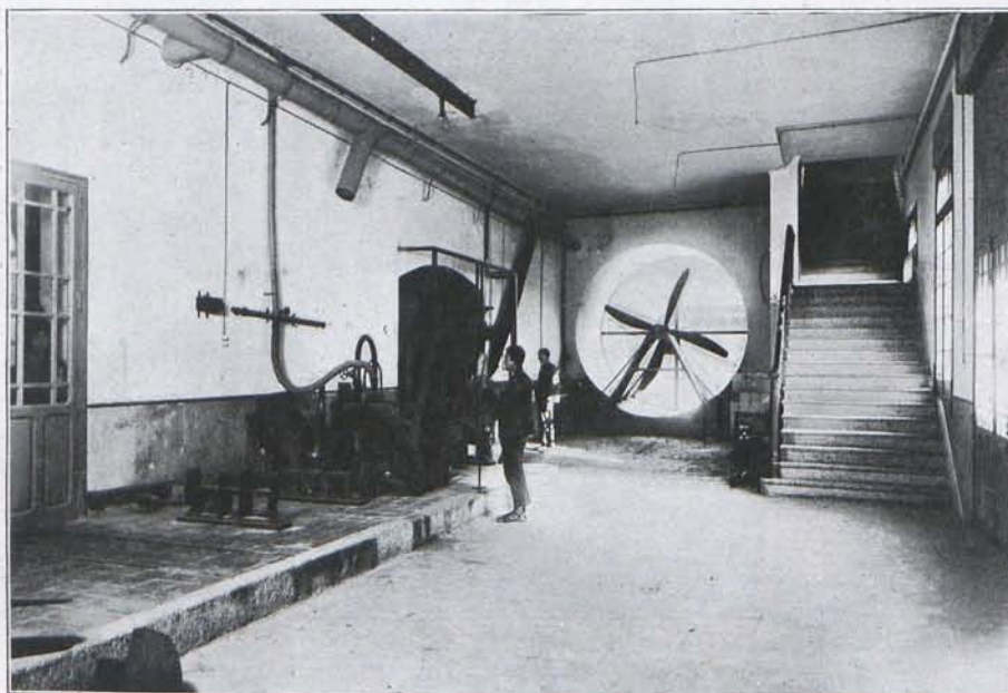
Vista del motor de 700 HP. que mueve la hélice del túnel. En el fondo, el «Pármetro», para determinar el par de giro de las hélices.
