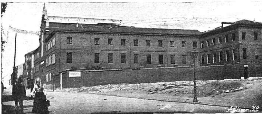
EXTERIOR DEL ASILO, VISTO POR EL COSTADO DE MEDIODÍA
