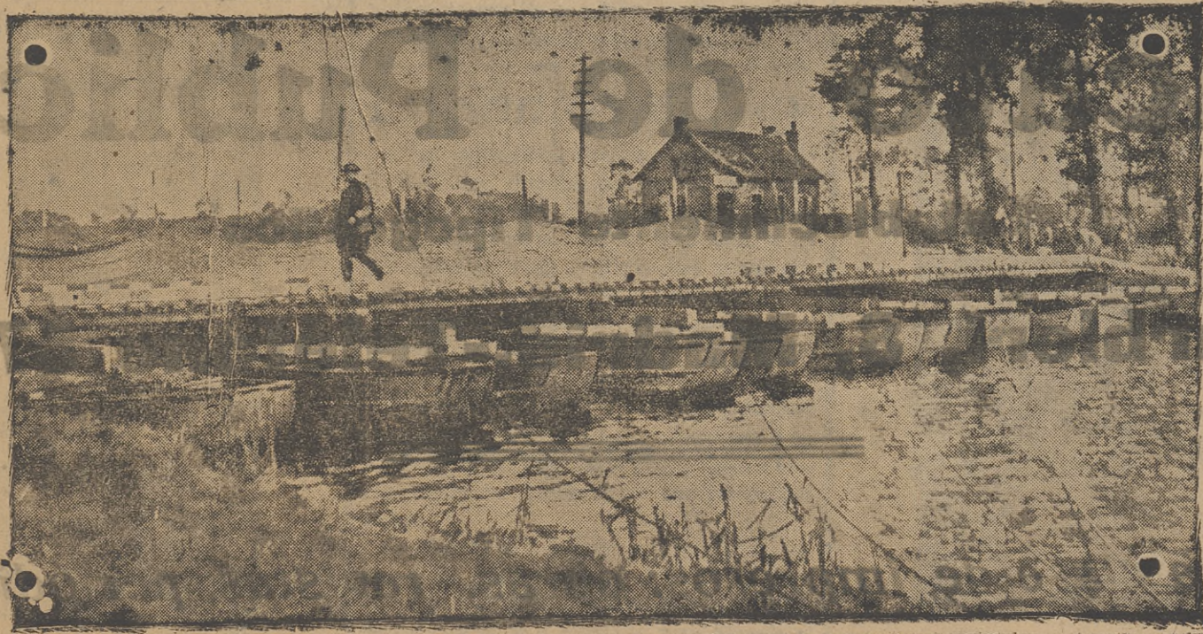
Puente de barcas en el Paso de Calais.—(Fot. Inf.)
