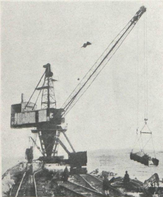
Figura 3.ª—Grúa Pillar, especialmente proyectada para la construcción del rompeolas principal del puerto de Haifa.
