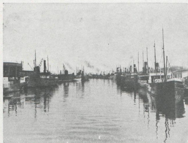
Figura 7.ª.—Puerto de Norrköping.
