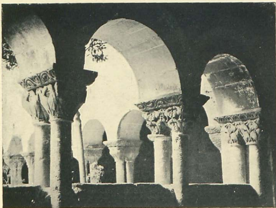
ARCOS DE LA GALERÍA SEPTENTRIONAL DEL CLAUSTRO
