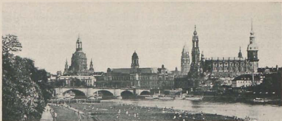
VISTA PARCIAL DE DRESDEN, CON SUS NUMEROSAS Y ESBELTAS TORRES, DESDE LAS ORILLAS DEL ELBA
