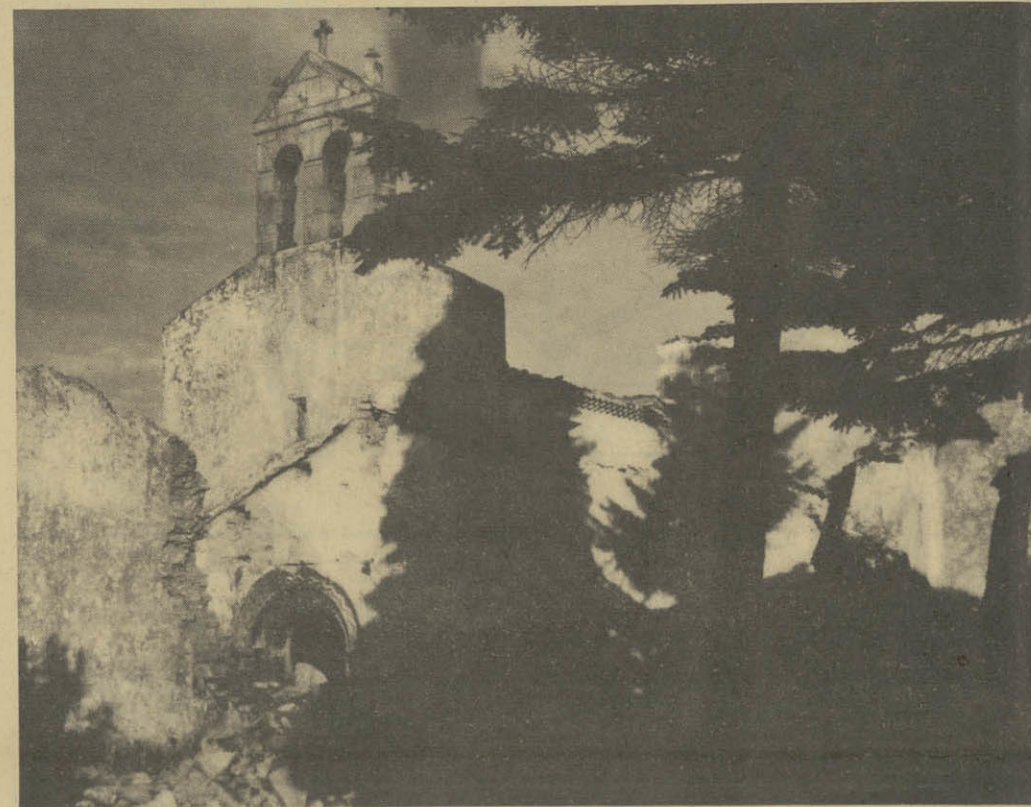
Trasana (Asturies), façade de l'église Saint-Vincent incendiée.
