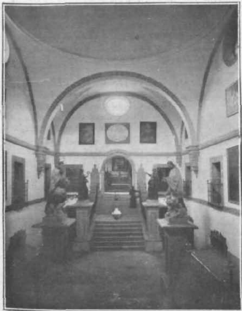
ESCALERA INTERIOR DEL COLEGIO.
