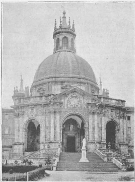
DETALLE DE LA FACHADA PRINCIPAL.
