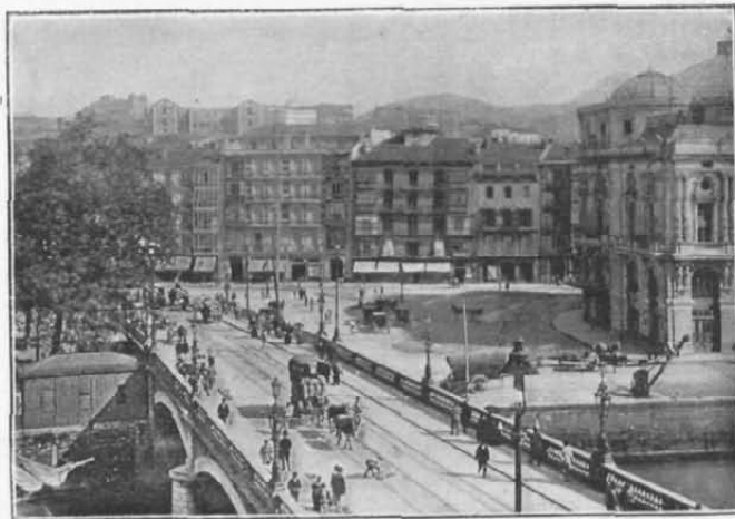
PUENTE DEL ARENAL.
